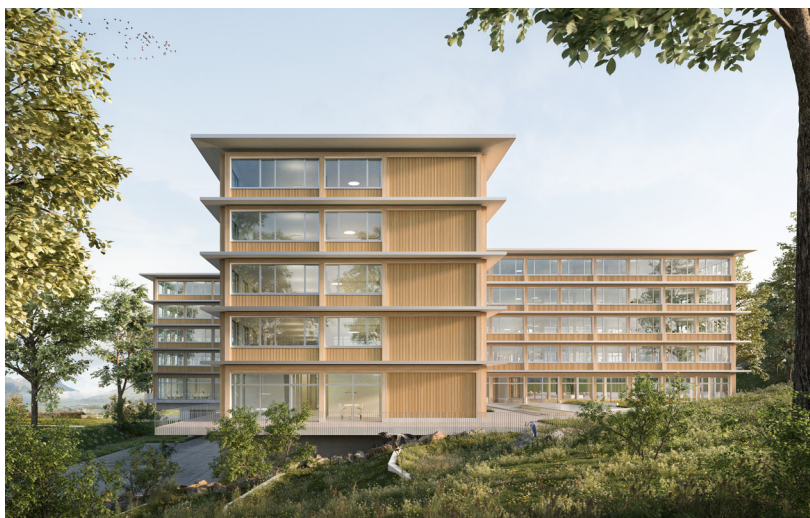
Die Südfassade des geplanten Verwaltungs- und Sicherheitszentrums.
