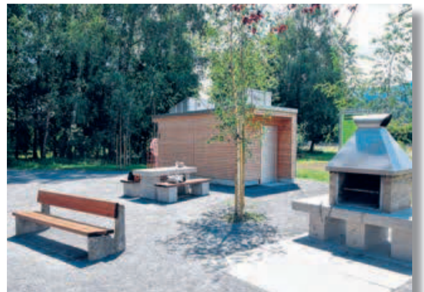
Das neue WC-Häuschen wird den Gästen gute Dienste leisten, ebenso wie Tische, Bänke und Feuerstellen.
