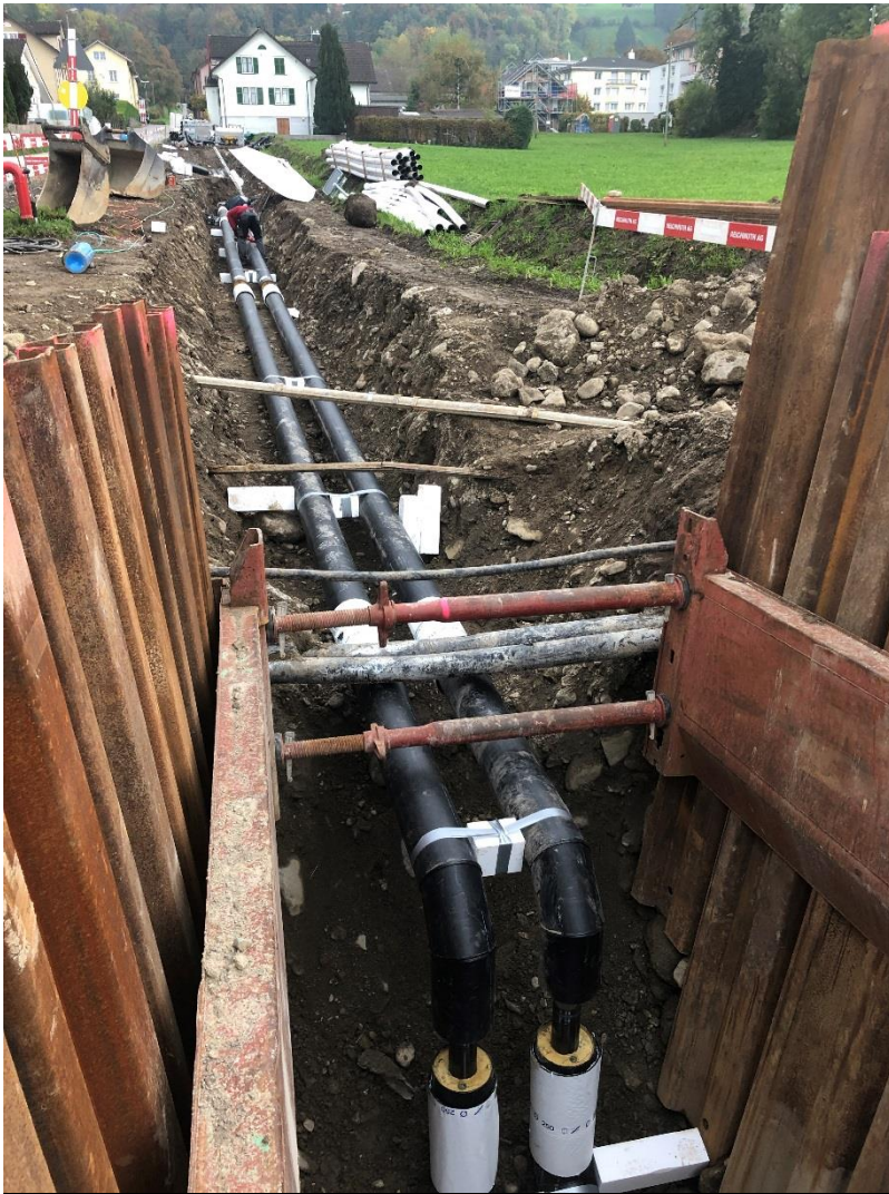
Abbildung 3: Beispiel eines Fernwärmegrabens aus dem Netz der Energie Ausserschwyz in Galgenen
