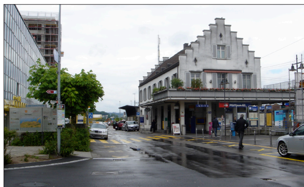
Abbildung 33: Das Stationsgebäude von 1931 strassenseitig (Foto: r.s. 2013).
