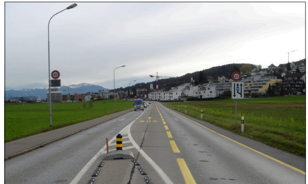
Abbildung 57: Zwischen Ried und dem Siedlungsgebiet von Pfäffikon bestehen auf einer Länge von ca. 300 m drei Fahrstreifen, wovon der mittlere eine Busspur in Richtung Pfäffikon ist. Rechts das Flachmoorobjekt von nationaler Bedeutung Langacker (Foto: r.s. 2013).
