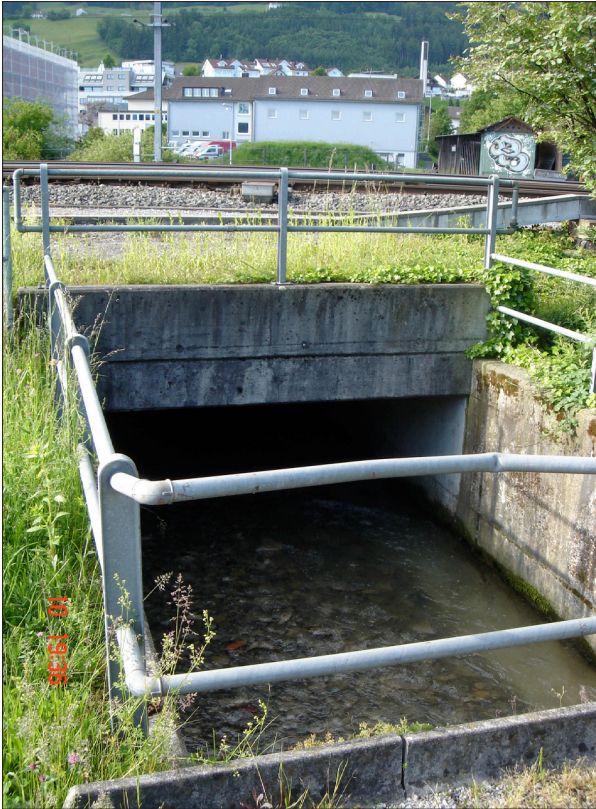
Abbildung 28: Der kanalisierte Staldenbach unter der Bahn. Blick nach Süden (Foto: r.s. 2013).
