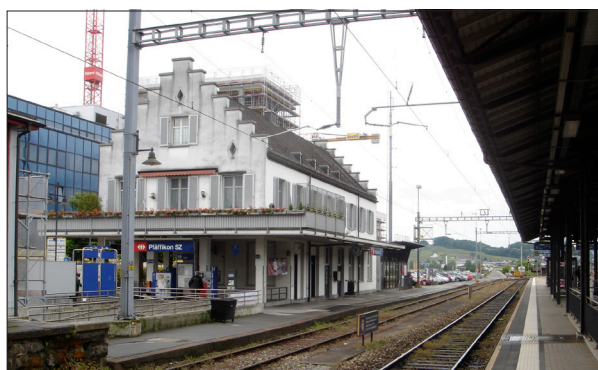
Abbildung 34: Das Stationsgebäude von 1931 schienenseitig (Foto: r.s. 2013).
