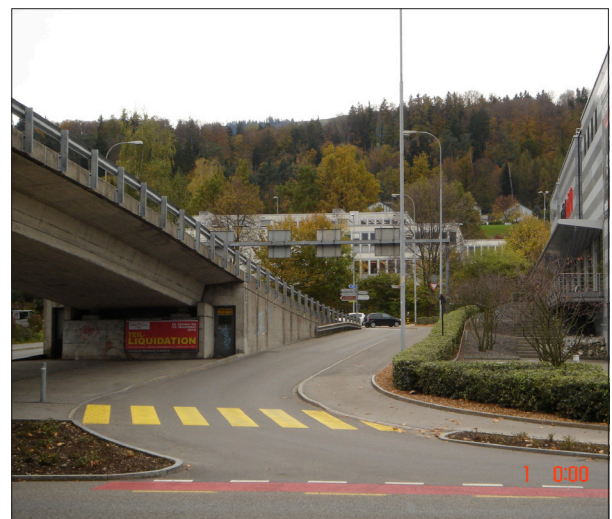
Abbildung 77: Die Gwattstrasse bei der Hochbrücke in Richtung Seedamm-Center etc. gemäss Wegweiser auf Abbildung 74 (Foto: r.s. 2013).
