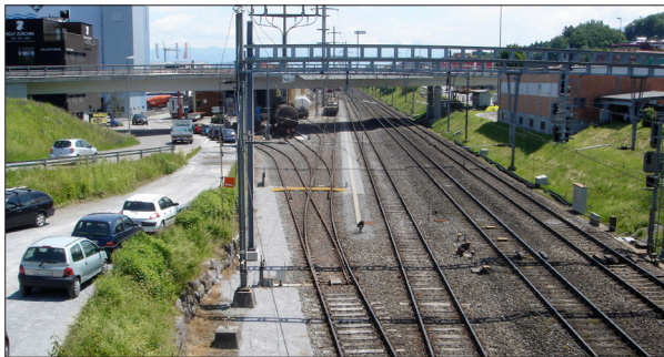
Abbildung 50: Blick von der Brücke der Seedamm-Strasse auf das Gleisfeld. Blick nach Osten (Foto: r.s. 2013).
