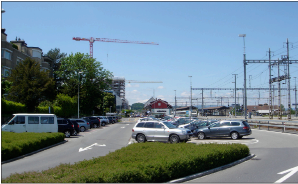
Abbildung 35: Blick von der Bahnhofstrasse Ostteil auf den Bushof. Im Hintergrund das alte Stationsgebäude (Foto: r.s. 2013).
