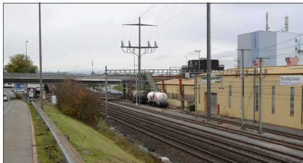
Abbildung 51: Blick von der Churerstrasse östlich des Etlzelpark-Knotens auf das Gleisfeld und die Industrie Hurdnerwäldli (Foto: r.s. 2013).
