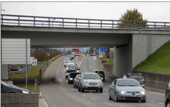
Abbildung 80: Blick in Richtung Altendorf. Hinten der Etlzelpark-Knoten. Die Brücke verbindet die A3 mit dem Seedamm (Foto: r.s. 2013).
