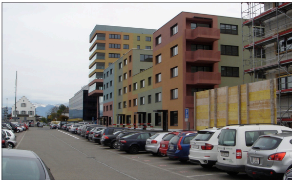
Abbildung 36: Blick vom Bahnweg auf die Überbauung Staldenbach und die P+R-Plätze. Im Hintergrund links das Stationsgebäude von 1931 mit Treppengiebel (Foto: r.s. 2013).
