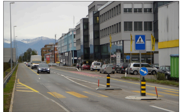
Abbildung 85: Blick auf die Kantonsstrasse in Richtung Altendorf ca. 150 m hinter dem Etlzelpark-Knoten. Hier endet die ca. 800 m lange Bus- und Radspur (Foto: r.s. 2013).
