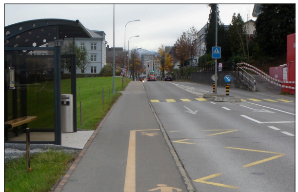
Abbildung 60: Bushaltestelle Rainstrasse in Richtung Freienbach (Foto: r.s. 2013).
