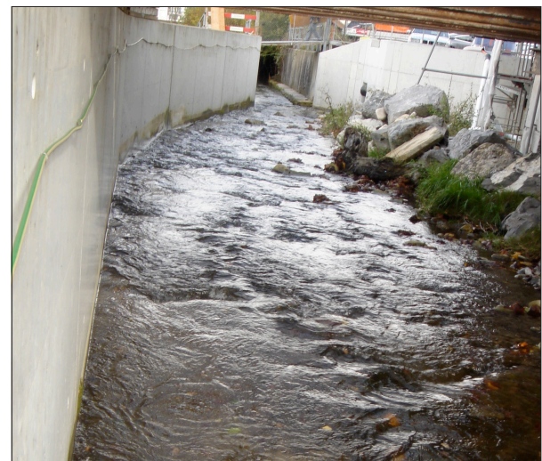
Abbildung 27: Der Staldenbach kurz vor der Bahnunterführung (hinten) bachabwärts (Foto: r.s. 2013).
