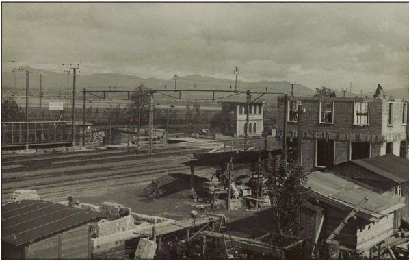
Abbildung 13: Bau des neuen Stationsgebäudes 1931 (Quelle: Gemeinde Freienbach).
