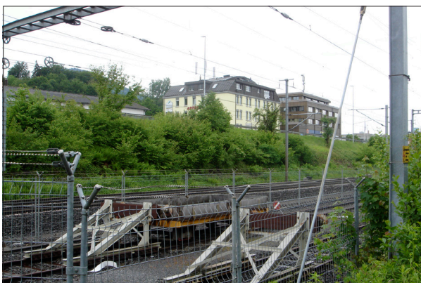
Abbildung 42: Die Abstellanlage der SBB. Blick nach Südwesten. Beachte die Geländekante mit der erhöht liegenden Churerstrasse (Foto: r.s. 2013).
